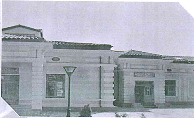
Reabilitare termică a clădirii din str.Vapoarelor nr. 2
