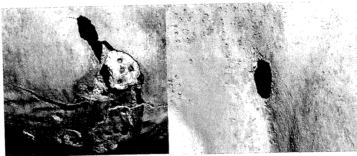
Coroziune sub tensiune mecanică.
