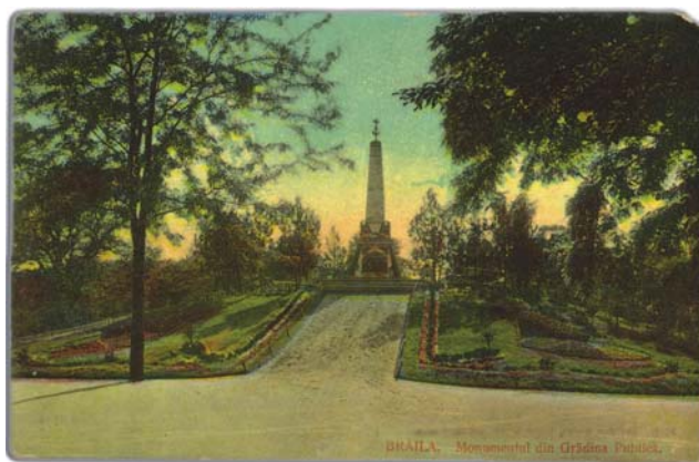
Parcul Monument. Monumentul închinat eliberării Brăilei, 1834 (distrus în 1917).
