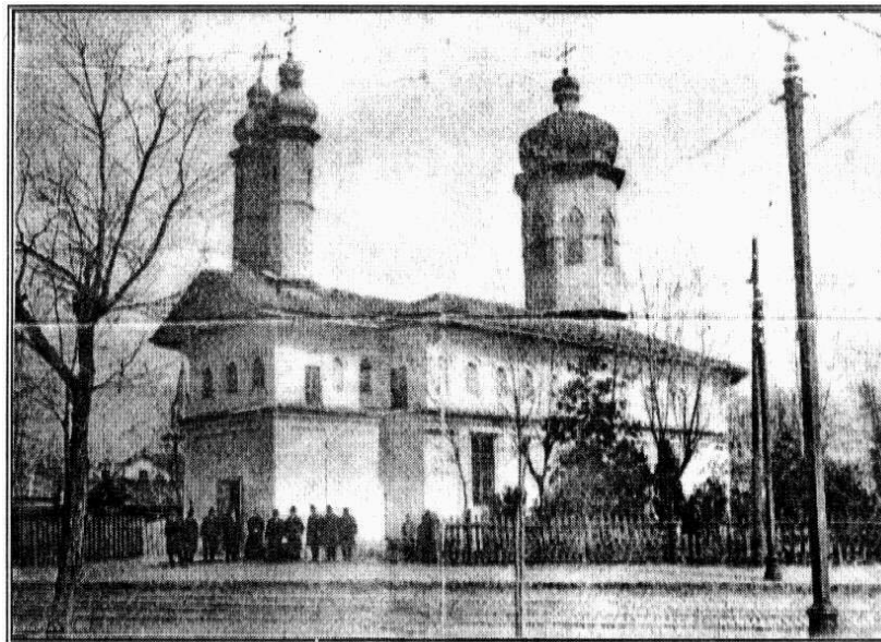
Bulevardul Independenței, colț cu Calea Călărașilor. Biserica Sf. Spiridon . Imagine de pe coperta cărții Rămășițele Proilaviei , de Pr. Ș. Sâmpetru (Brăila, 1996)
