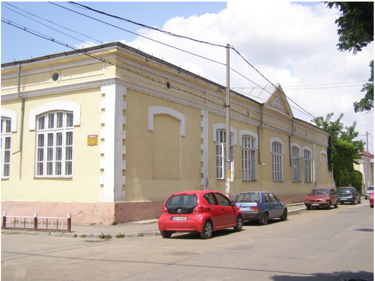
Strada Ștefan cel Mare. Arhitectură de la sfârșitul secolului XIX.
